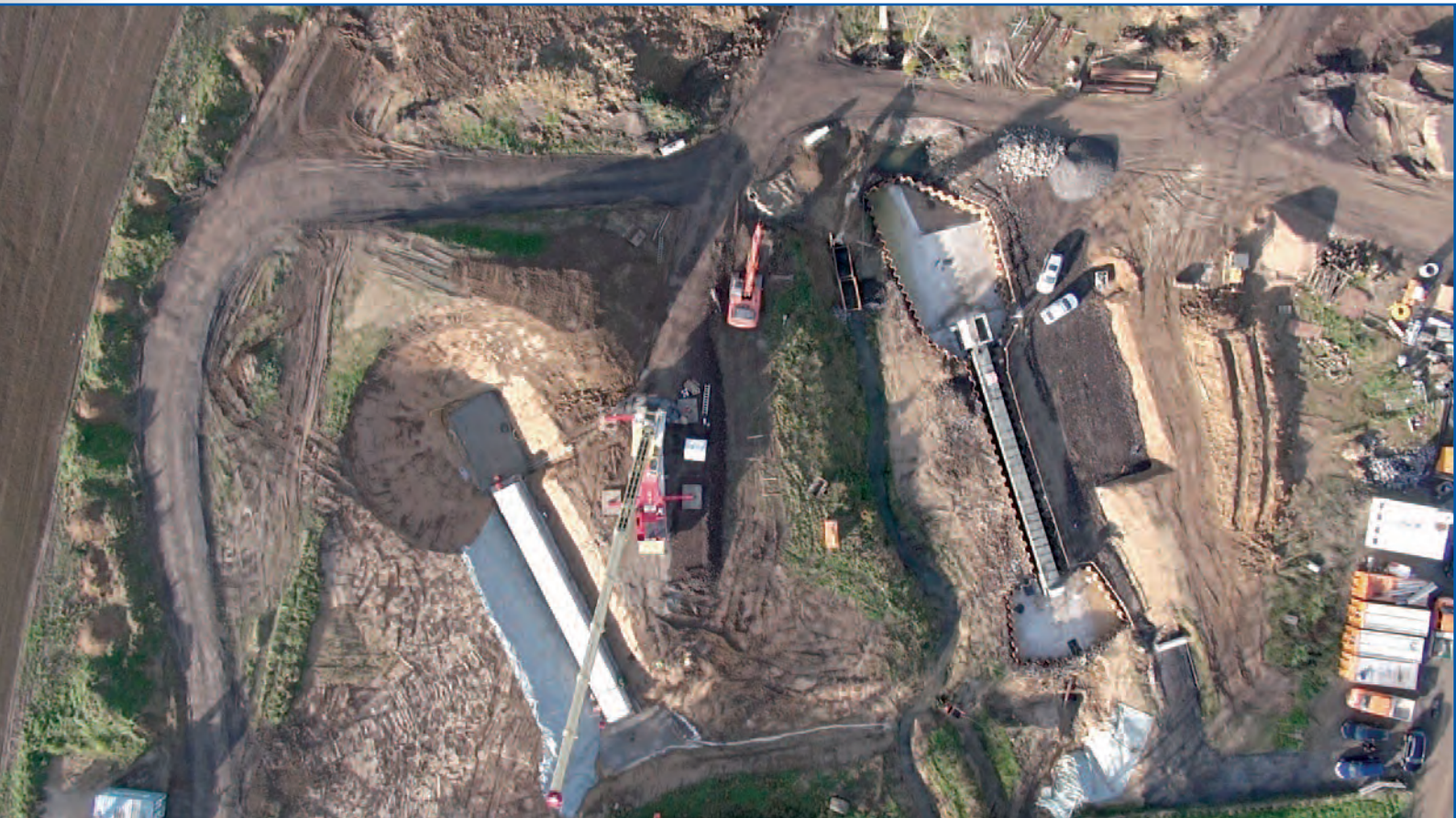
Drohnenfoto Hochwasserrückhaltebecken Nierendorf 2015
