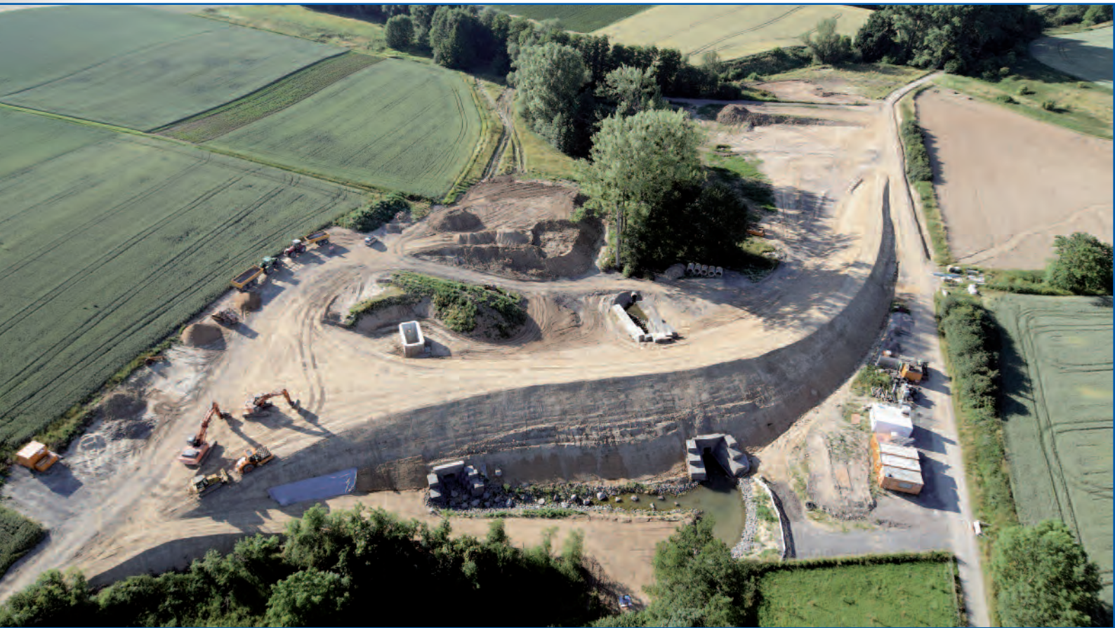
Drohnenfoto Hochwasserrückhaltebecken Nierendorf 2015
