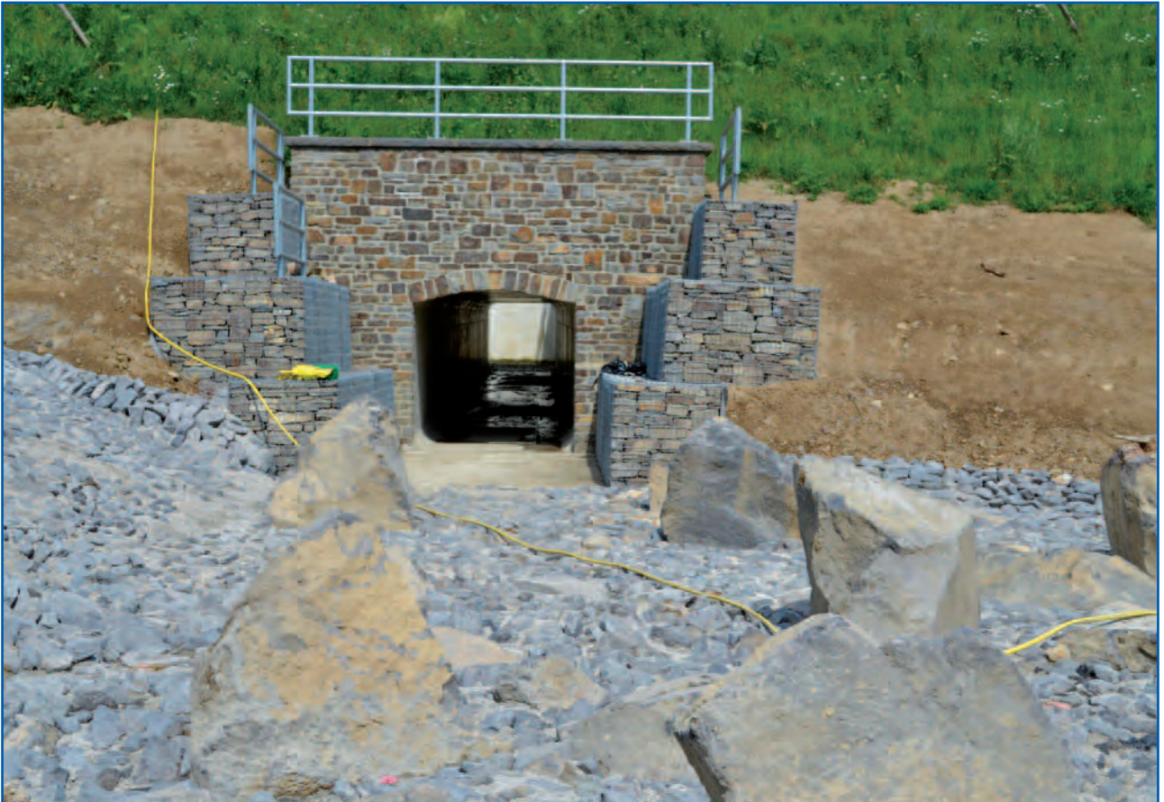
Neu gestaltetes Tosbecken mit Raubetrinne des Hochwasserrückhaltedammes Nierendorf im Sommer 2018
