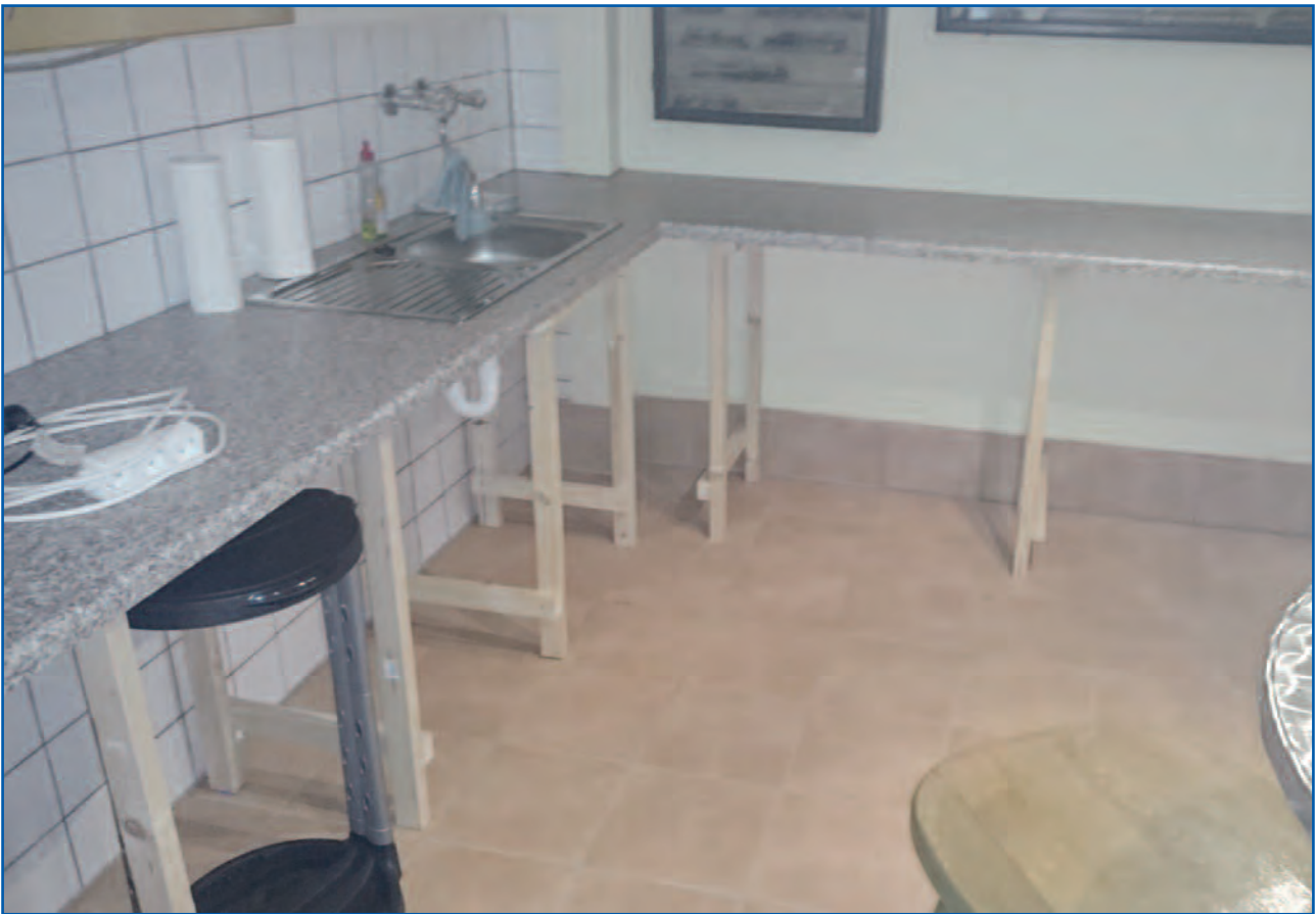
Verzicht auf Unterschränke bei der Kellerküche in einem Privathaus in Nierendorf
