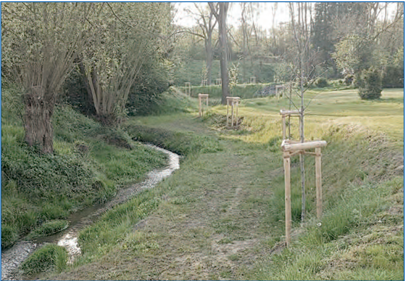
Gewässerrenaturierung des Leimersdorfer Baches in Nierendorf innerorts 2017
