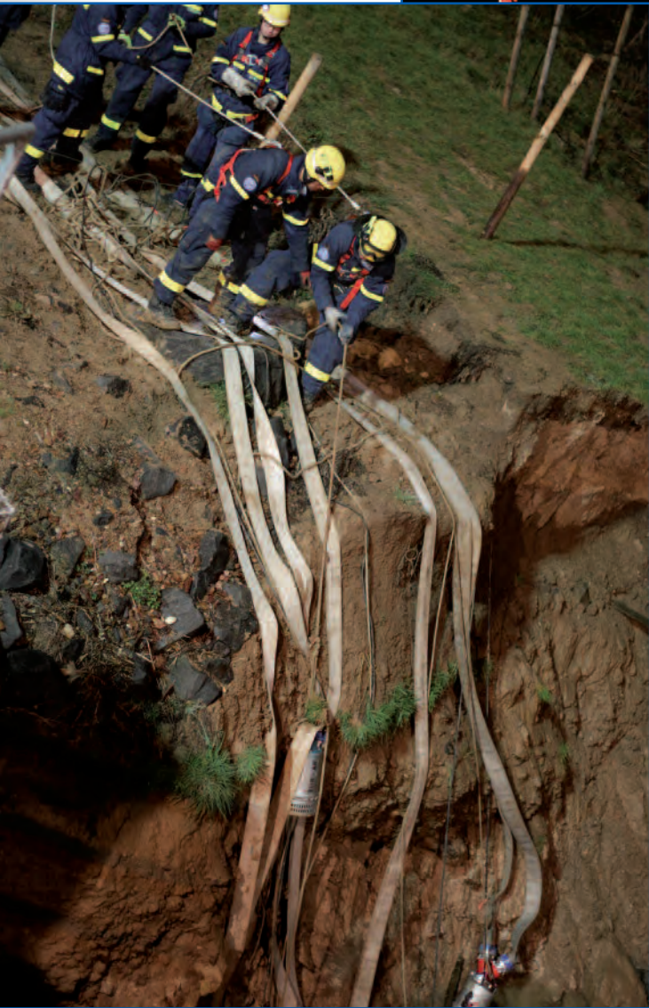
Auspumpen des beschädigten Tosbeckens und gemeinsame Übung der FFW untere Grafschaft und des THW Bad Neuenahr-Ahrweiler
