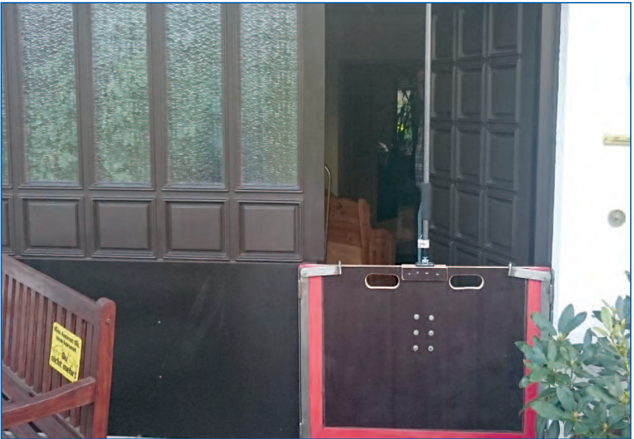
Mobile Flutsperre an einem Wohnhaus in Nierendorf
