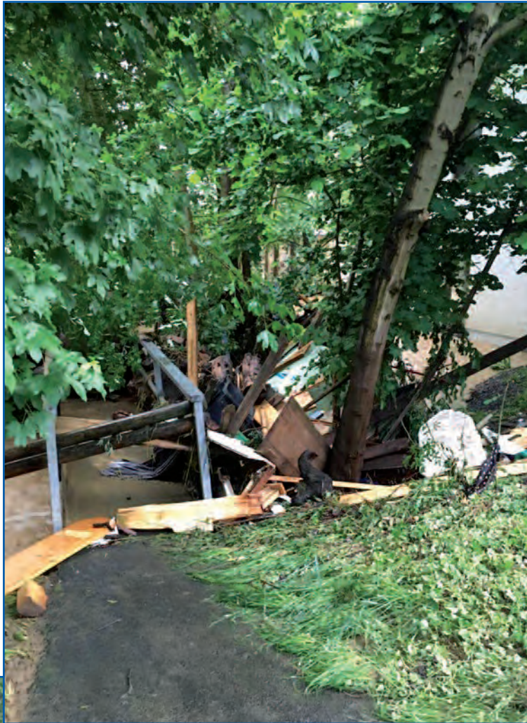
Verklausung Nierendorf innerorts vor einer Fußgängerbrücke, Starkregenereignis 2016
