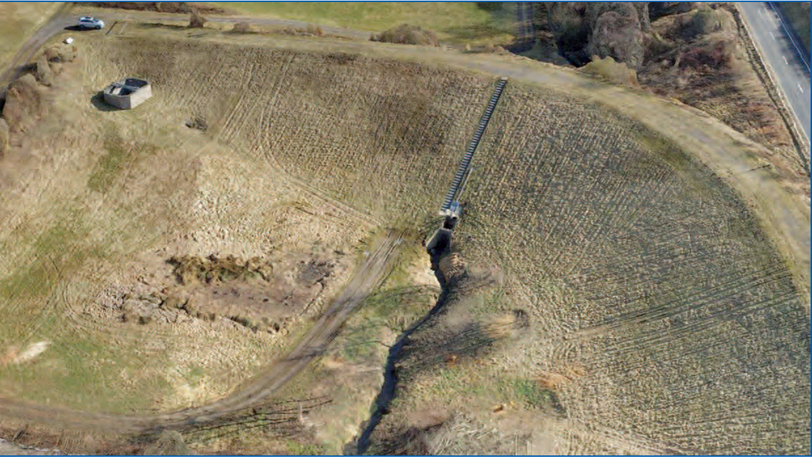
Drohnenbefliegung des Hochwasserrückhaltebeckens Bengen Juni 2018
