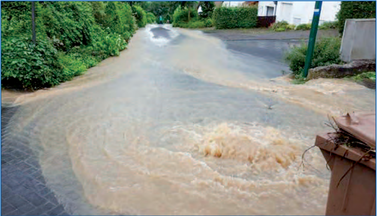
Überbelastetes Kanalsystem in Birresdorf, Starkregenereignis 2016
