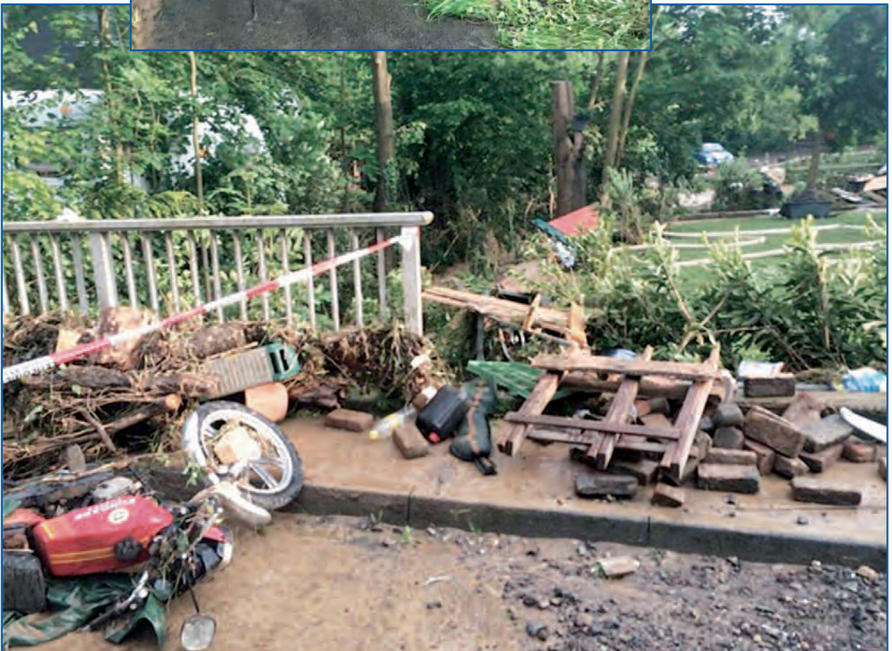
Verklausung Nierendorf innerorts an einer Fußgängerbrücke, Starkregenereignis 2016, Front- und Seitenansicht
