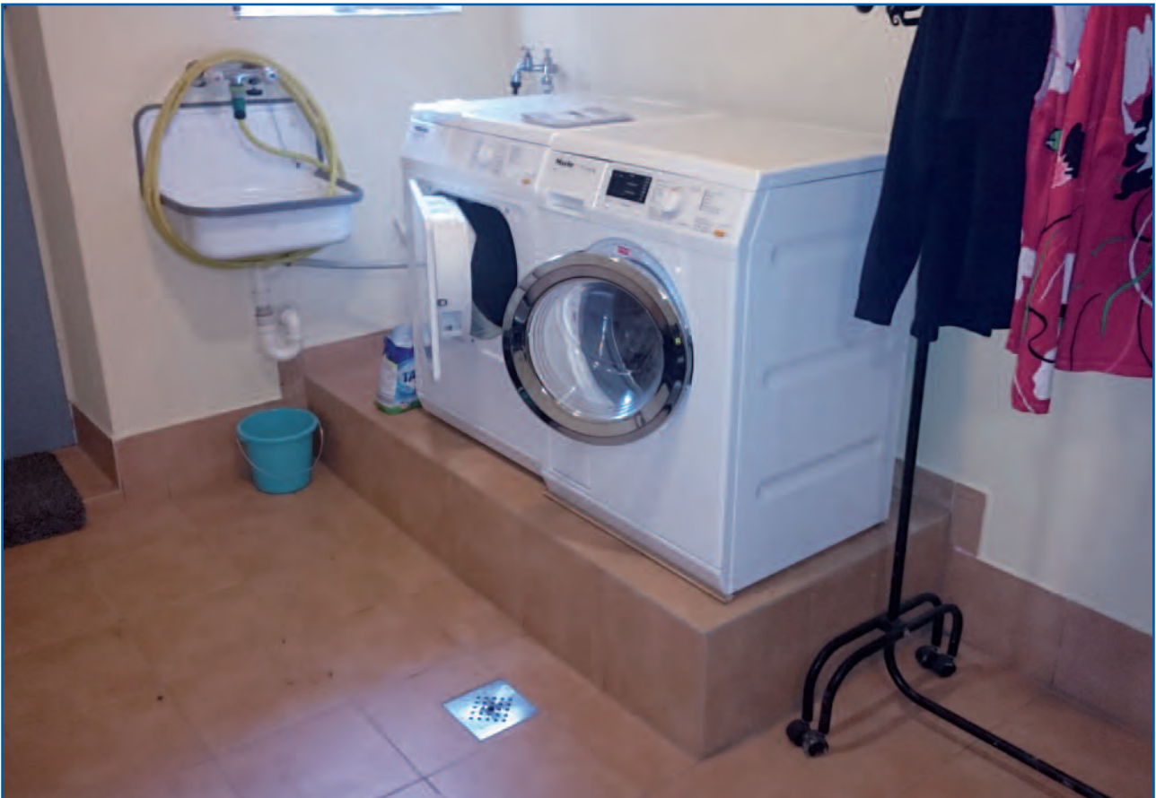
Hoch gesetzte Elektrogeräte im Kellerraum eines Privathauses in Nierendorf
