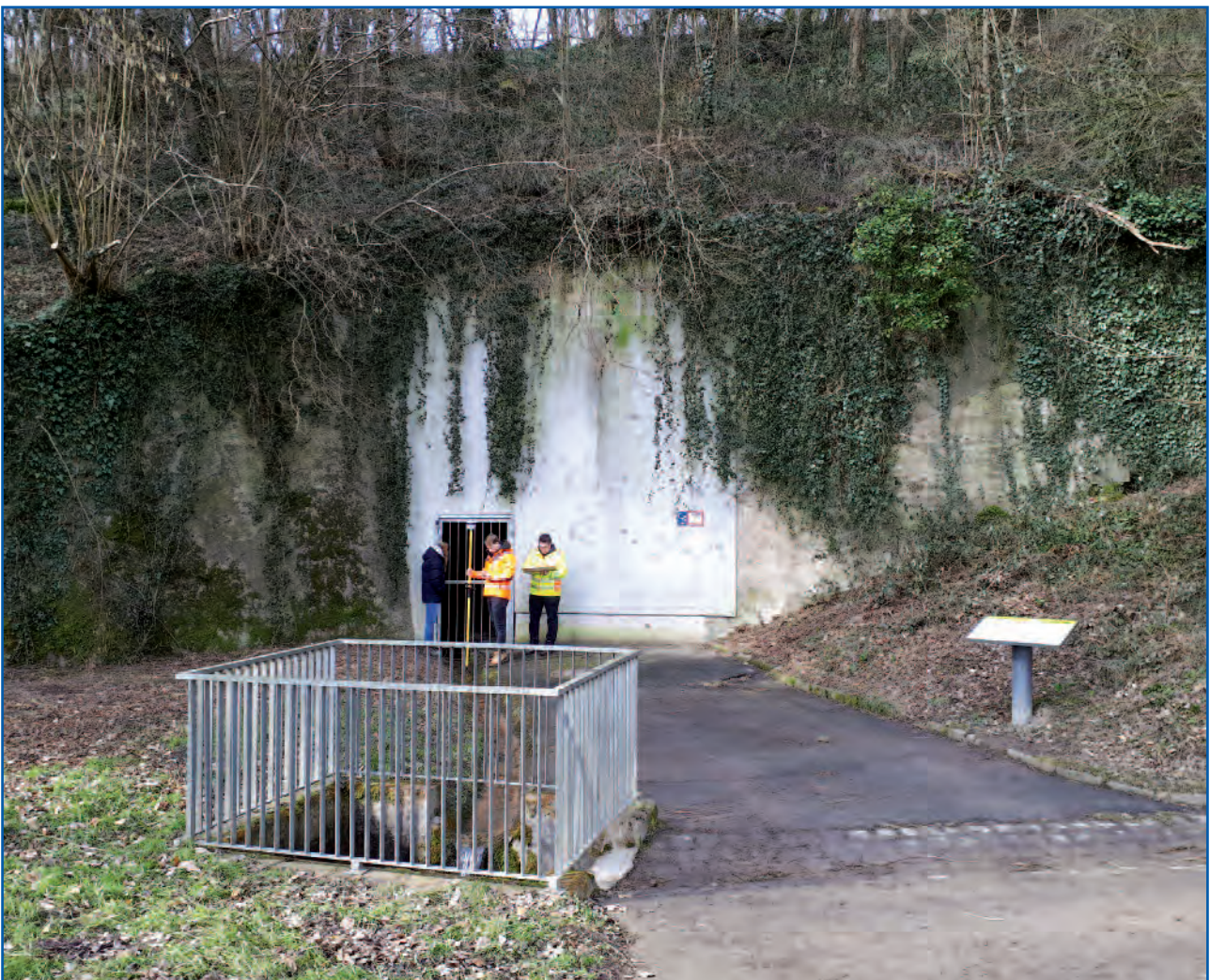
Vermessung des Einlaufbauwerkes am Fuchsbach in Lantershofen
