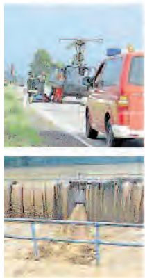
Unten: Überlauf des Regenrückhaltebeckens Gimmigen. Oben: Hubschrauber in Bereitschaft
