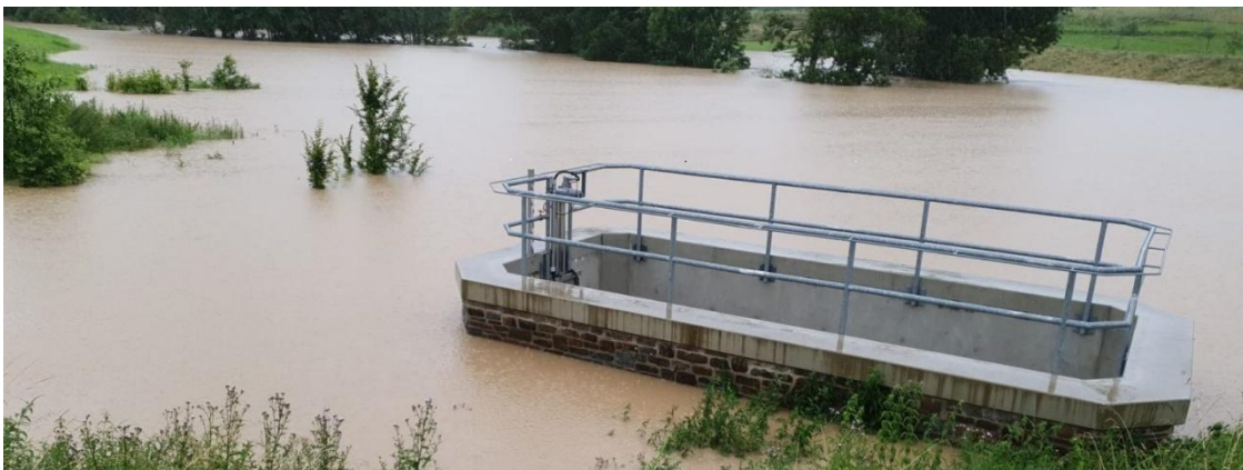
Abb. 3: Einstauung im Hochwasserrückhaltebecken Nierendorf, eigene Aufnahme, 2024
