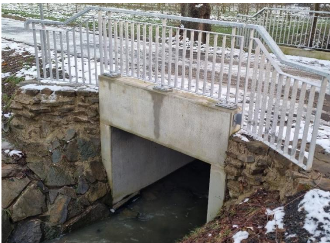
Abb. 28: Neubau des Brückenbauwerks „Oberescher Weg“ 2024, eigene Aufnahme
