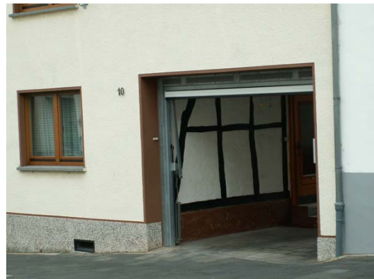
Bild 30 Karweilerstraße 10, altes Fachwerk unter neuer Fassade „versteckt“
