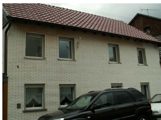
Bild 12 Brennerstraße 4. Kunststoffverkleideter Altbau, nicht ortstypisch
