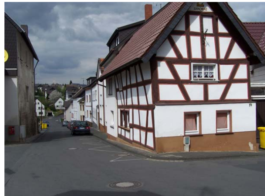
Bild 32 Karweilerstraße vom Ortskern ausgehend (siehe auch Bild 39)
