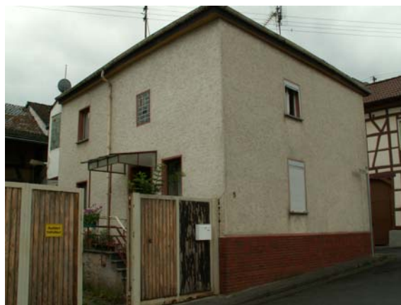
Bild 50 Am Frummech 5, Gebäude im Ortszentrum mit baulichen Mängeln
