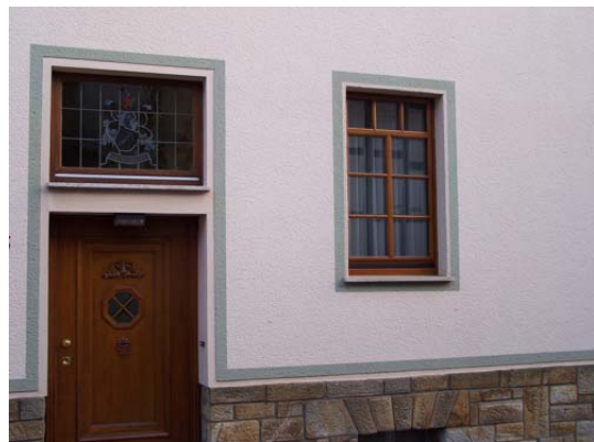
Bild 22 Schmittstraße 3, Detail der sanierten Gebäudefront, Fensterteilung und gelungene Farbgestaltung
