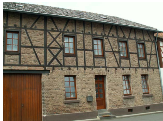
Bild 34 Graf-Blankert-Straße 3, Fachwerk mit Ziegelstein ausgemauert
