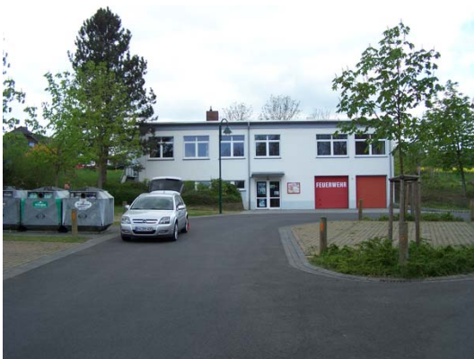
Bild 5 Mehrzweckhalle und Feuerwehrhaus
