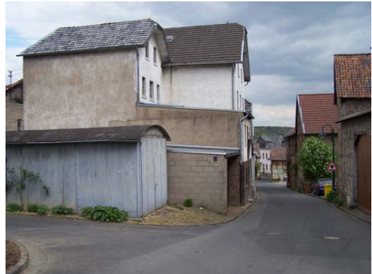
Bild 24 Schmittstraße 12, Mühle. In diesem engen Bereich der Schmittstraße fehlen die Bürgersteige
