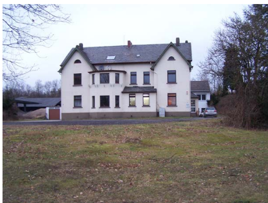
Bild 69 „Auf Schäfers Burg“, Bürogebäude von 1912
