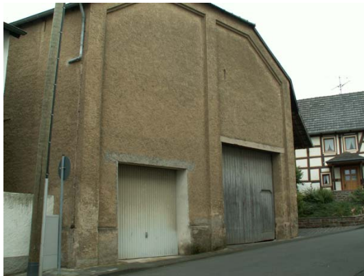
Bild 41 Überdimensioniertes landwirtschaftliches Gebäude in der Winzerstraße
