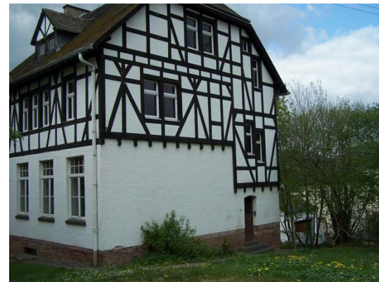
Bild 46 Die „Alte Schule“ von der Gartenstraße betrachtet
