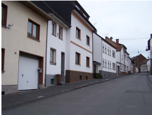
Bild 29 Karweilerstraße, mittlerer Bereich, kein Straßenbegleitgrün. Hausbegrünung wäre hier vorteilhaft
