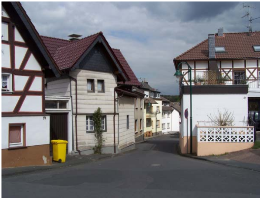
Bild 35 Winzerstraße vom Ortskern ausgehend, stark veränderte Fachwerkgebäude
