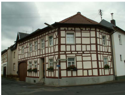
Bild 33 Graf-Blankert-Straße 9. Die Fassade wirkt nicht mehr „frisch“.
