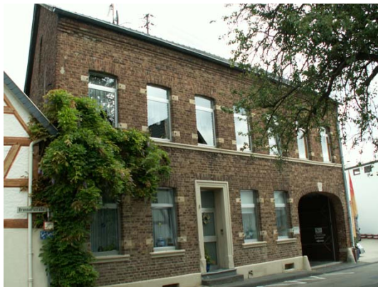
Bild 14 Rheinstraße 1, gut erhalten und begrünter Klinkerbau, Fenster leider aus Metall und Tür nicht originalgetreu
