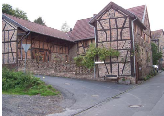
Bild 23 Schmittstraße 11. Fachwerk mit Ziegelsteinen ausgemauert
