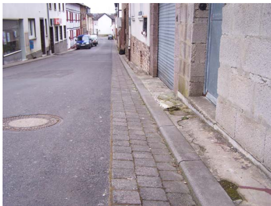
Bild 22 Bengener Straße, Höhe „Auf dem Justen“. Detailaufnahme Bürgersteige
