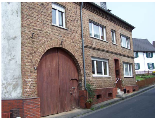
Bild 36 Ringenerstraße 6, „Klinkerbau“ aus der Gründerzeit
