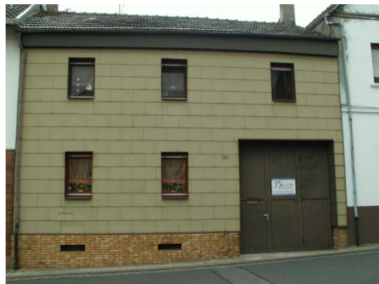
Bild 23 Bengener Straße 20, nachweislich altes Haus hinter neuer Kunststoffverkleidung
