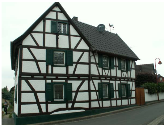
Bild 28 Weierstraße 1, gut erhaltenes Fachwerkgebäude, ortsbildprägend
