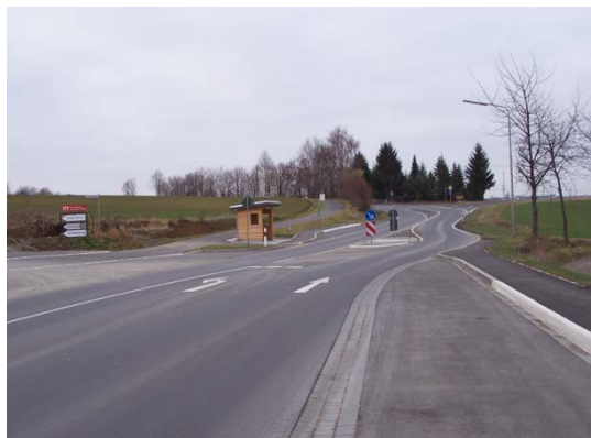
Bild 13 Bushaltestelle außerhalb des Ortes, Querungshilfe auf der Fahrbahn
