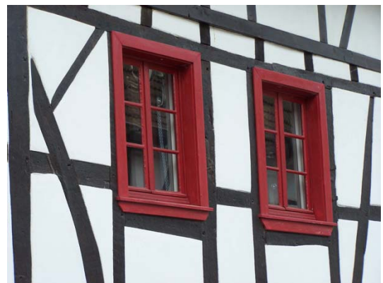
Bild 19 Bengener Straße 13, ortstypische Fenster mit Sprossen, fachgerecht aufgearbeitet
