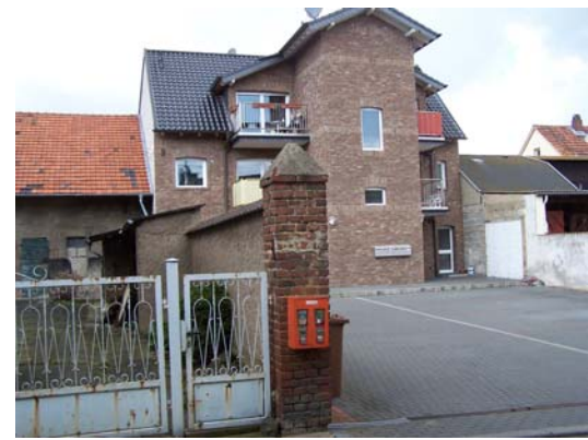
Bild 35 Weierstraße 18 zur Bengener Straße. Raumkante durch Parkplatz „aufgerissen“. Gestaltung nicht dorfgerecht.
