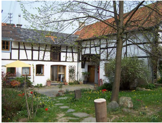
Bild 20 Bengener Straße 16, Hof Geller, gut erhaltenes und saniertes Gehöft
