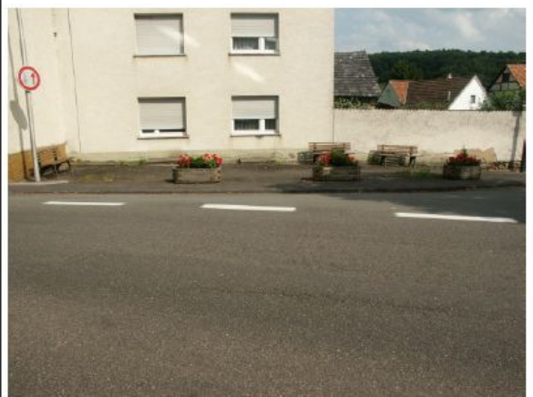
Gestaltungsmängel im Straßenraum Kreuzungsbereich Pützstraße / Vettelhovener Str.
