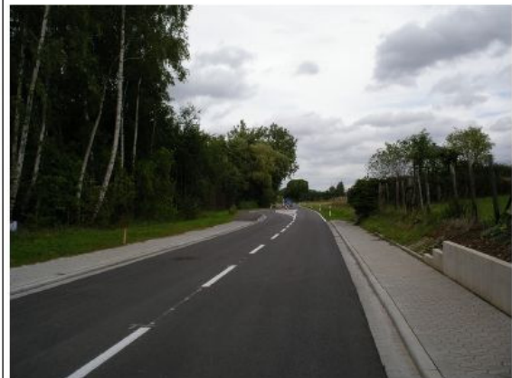
Neu gestaltete Ortseinfahrt von Vettelhoven kommend mit geschwindigkeitsdämpfender Maßnahme
