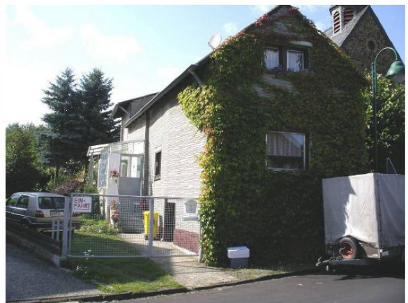
ortsbildprägendes Gebäude /stark überformt
