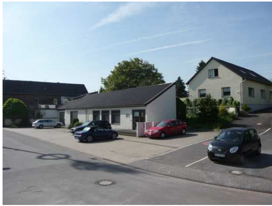
Bild 33 Ehemaliges Raiffeisengebäude mit Parkplätzen, Blick aus Richtung „Am decke Steen“
