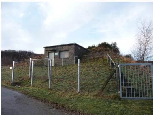
Bild 73 Altes Wasserhäuschen nahe der Gewerbeparks Gelsdorf
