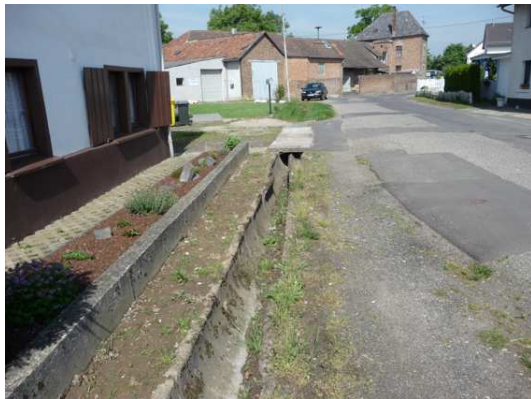
Bild 47 Offener Graben in der Eckendorfer Straße
