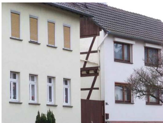
Bild 7 Bonner Straße 20a, von vorne nicht als Altgebäude zu identifizieren, Fachwerkhaus mit vorgesetzter Fassade
