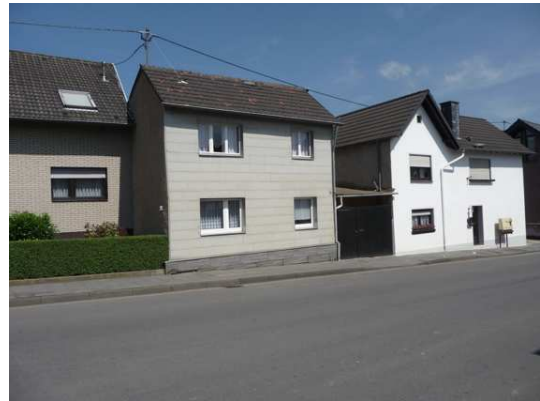
Bild 4 Bonner Straße 11 und 13, beides stark veränderte Fachwerkhäuser
