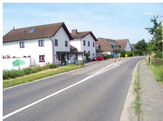
Bild 44 Ortseingang Neuenahrer Straße mit Verkehrsberuhigungsmaßnahmen
