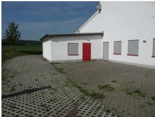
Bild 71 Gelände hinter der Mehrweckhalle
