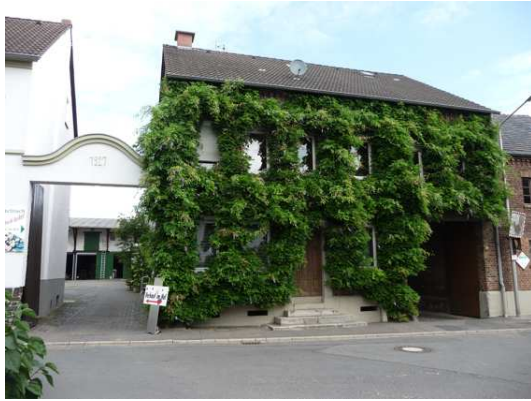
Bild 21 Hausbegrünung an der Bonner Straße 81
