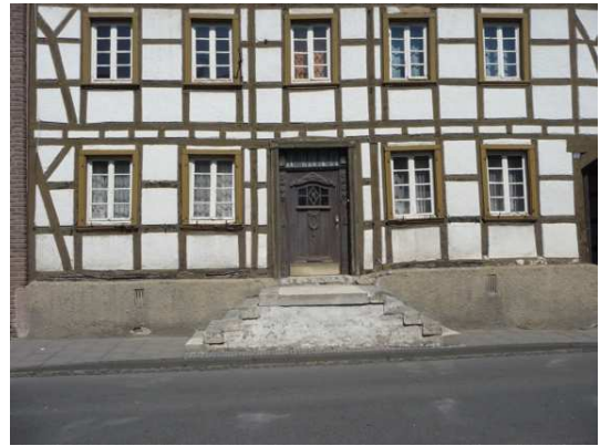
Bild 16 Bonner Straße 63, Fachwerk mit Treppe zum Eingang
