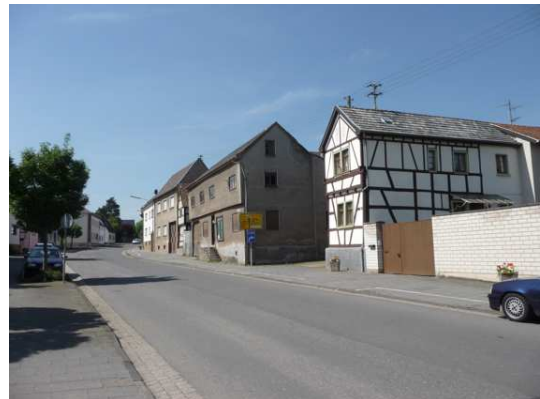
Bild 6 Bonner Straße 27, Fachwerkhaus mit Giebel zur Straße
