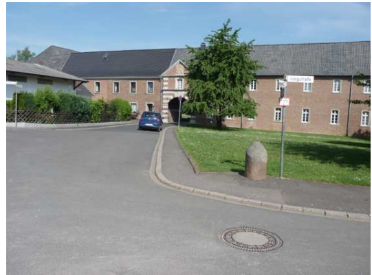
Bild 28 „Am decke Steen“, Burganlagen mit Wohnanlagen
