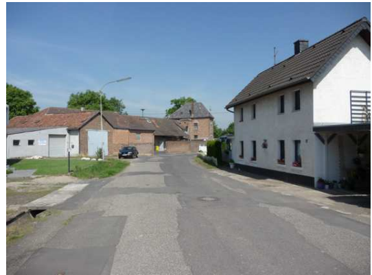
Bild 46 Blick in die Eckendorfer Straße, keine Fußwege, häufig ausgebesserte Straßendecke
