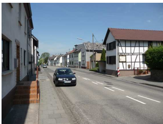
Bild 43 Blick in die Dürener Straße aus Richtung Kreuzung, Hausbegrünungen und Bepflanzungen im Straßenraum könnten hier die Aufenthaltsqualität steigern
