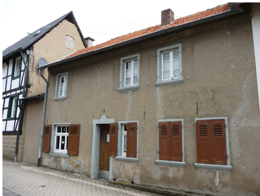
Bild 11 Ginngasse 4, Wohngebäude mit ehem. Schusterwerkstatt im Erdgeschoss
