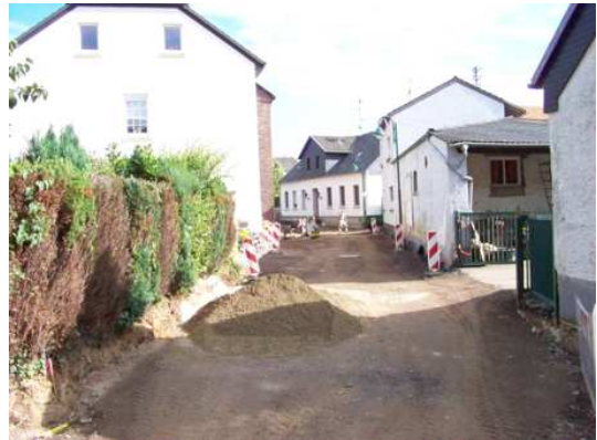
Bild 48 Die Schulstraße während der Bauarbeiten im Jahr 2010. Im Hintergrund die „Alte Schule“
