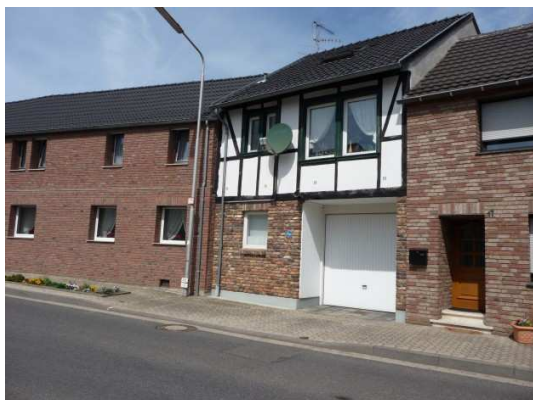
Bild 43 Scheidstraße 15. Stark verfälschte Fassaden von mutmaßlichen Altbauten
