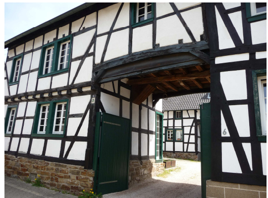
Bild 12 Ginngasse 6, ortsbildprägendes, gut erhaltenes und saniertes Fachwerkhaus mit Wohnnutzung
