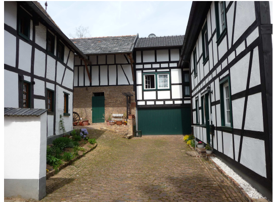
Bild 36 Lappsgasse 3 (historisch) und 5 (Neubau), ortsbildprägendes Fachwerkgehöft
