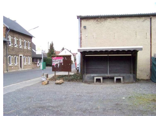
Bild 20 Das Warte-Häuschen steht "geduldet" auf privatem Grundstück
