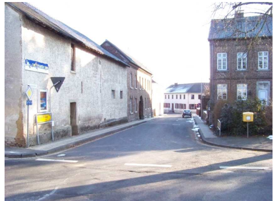
Bild 40 Blick von der Graf-Otto-Straße in die Scheidstraße. (Gebäude Bahles links, Pfarrhaus rechts)
