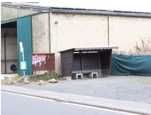
Bild 19 Bushaltestelle Ostseite. Im Hintergrund die Idw. Halle Fuchs
