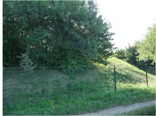
Bild 62 Der Hochbehälter von der Ostseite
