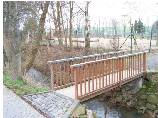
Bild 6 Die Fußgängerbrücke über den Swistbach zum Spiel- und Bolzplatz
