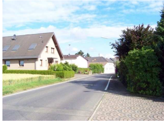
Bild 34 Ortseingang mit Blick auf Graf-Otto-Straße 36. Fußgänger, die links aus der „Hinteren Gasse“ kommen finden keinen Gehweg vor.
