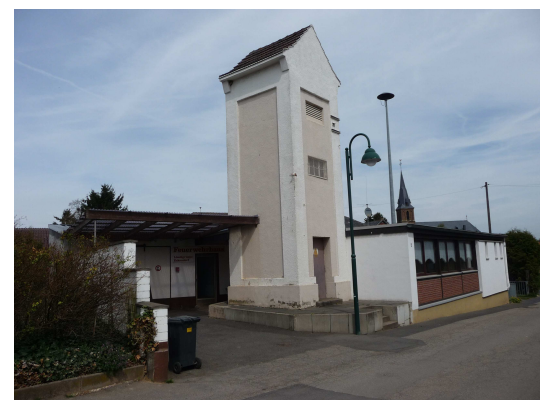
Bild 50 Das Feuerwehrhaus im „Schmaler Weg“
