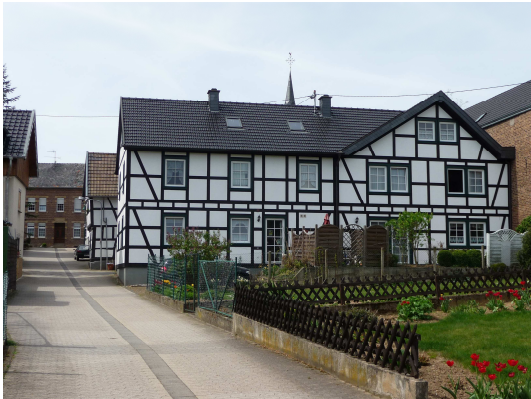
Bild 35 Lappsgasse, Blick aus Richtung Swistbach, Lappsgasse 5 im Vordergrund, Neubau in Fachwerkbauweise
