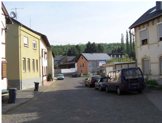
Bild 11 Bachstraße aus Süden, Blick auf den entstehenden Neubau
