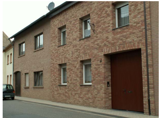
Bild 24 Gimmiger Straße 21 und 23, die voll verkleideten Gebäude wirken steril und könnten durch Begrünung aufgewertet werden
