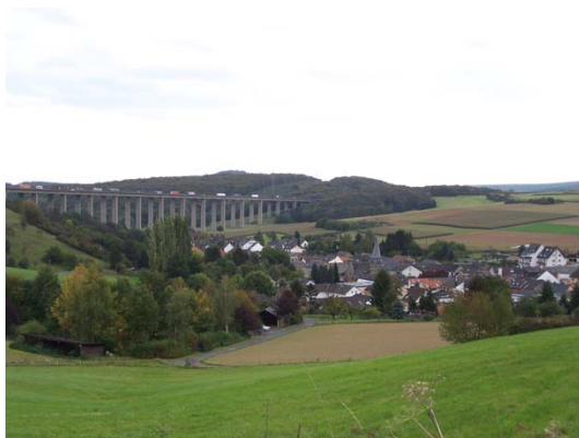
Bild 7 Ortsansicht Bengen aus Norden, im Hintergrund die Autobahnbrücke der A 61
