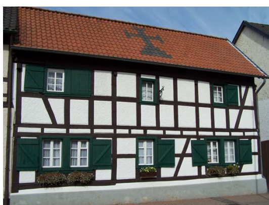
Bild 29 Kirchstraße 5, gut erhaltenes Fachwerkhaus mit dorftypischen Sprossenfenstern und Fensterläden
