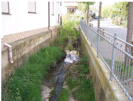
Bild 5 Bengener Bach in der Flurstraße, der Bach fließt hier offen in einem Beton-Kanalbett
