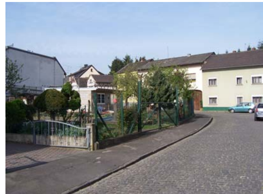
Bild 12 Bachstraße im westlichen Abschnitt, unter dem Bürgersteig verläuft der Bengener Bach.
