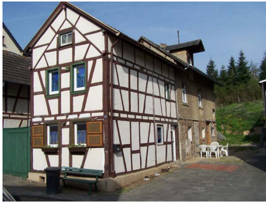
Bild 9 Bachstraße 1. Fachwerkhaus, Leider Kunststofffenster ohne Teilung
