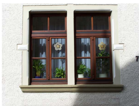
Bild 30 Kirchstraße 7, Fensterdetail. gelungen sanierter Gründerzeitbau von 1910
