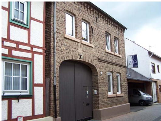
Bild 17 Bogenstraße 8, „Klinkerbau“ aus der Gründerzeit
