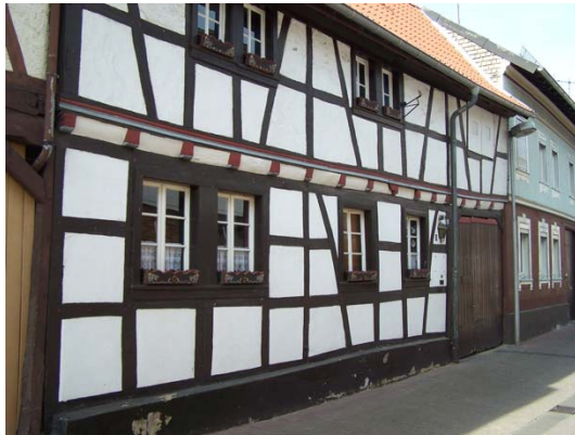
Bild 15 Bogenstraße 5. Ortsbildprägendes, gut erhaltenes Fachwerkhaus
